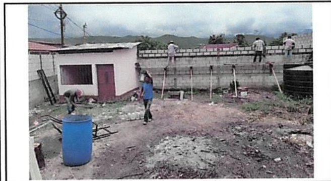
SUSTITUCIÓN DE MURO PERIMETRAL
