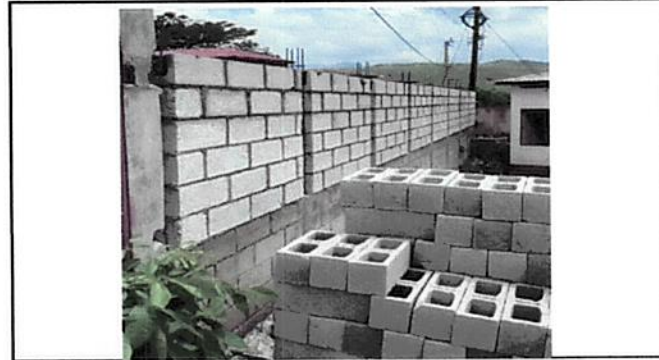
SUSTITUCIÓN DE MURO PERIMETRAL
